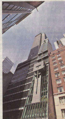
80 Meter hoch auf minimaler Grundfläche: Das ACFNY. Foto: ACFNY/Plakke
